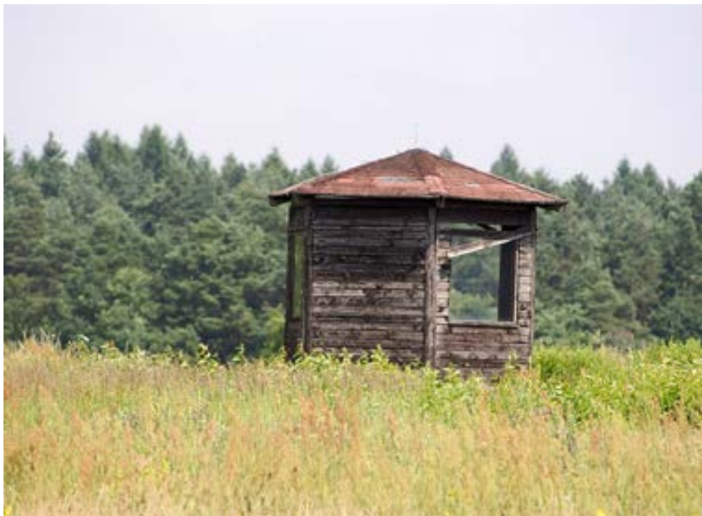
Gerade einladend bei Donner und Blitz sieht diese Schutzhütte nun wirklich nicht aus
