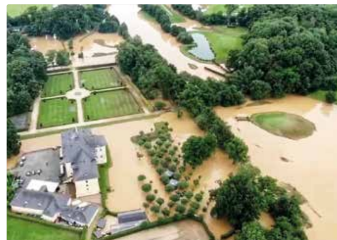
Das Hochwasser hat seine Spuren hinterlassen
