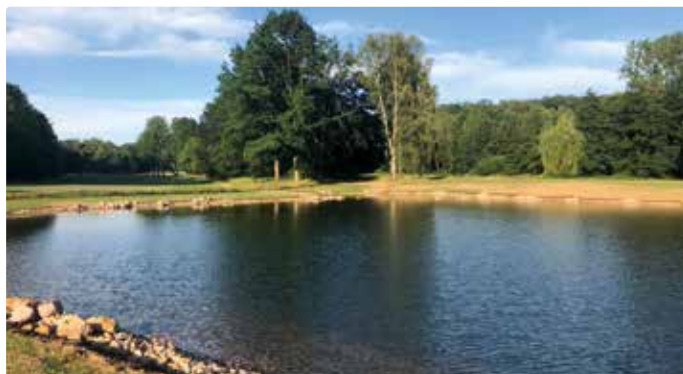
Neubau Speicherteich (2.500 qm) und neue Fairwayberegnung Essener Golfclub Haus Oefte
